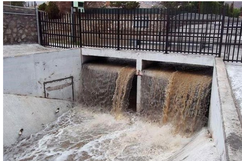
El Paso storm water project, El Paso, TX
